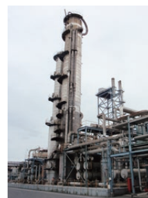
写真4：アンモニア製造設備で合成ガスをアンモニアにする。
